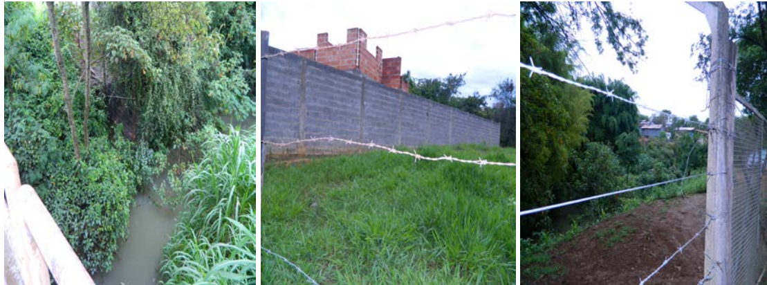
Figura 10: Ocupação irregular do solo encontrado no local
