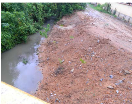
Figura 3: Supressão de vegetação, perda de revestimento do solo.
